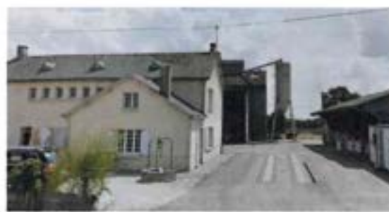
L'Herminette Combustible, entreprise située rue du Relais de poste Juillet 2018
